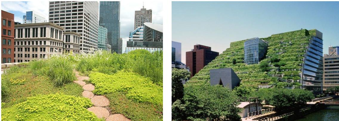
*Ilustración 4-14: La instalación de vegetación en las azoteas genera un gran número de co-beneficios. Además de reducir y frenar la escorrentía de las aguas pluviales en entornos urbanos, producen oxígeno, proporcionan sombra y reducen el calor en las ciudades (en la imagen de la izquierda el ayuntamiento de Chicago, USA y a la derecha ACROS-Fukuoka Prefectural International Hall, Japón).*
