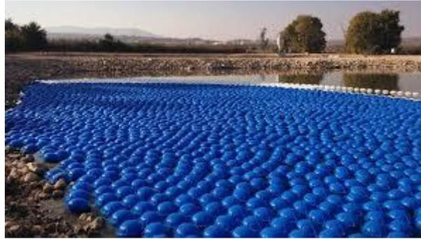
*Ilustración 4-22: Dado el gran número de balsas existentes, fundamentalmente para riego, la cubrición de las mismas es fundamental para evitar pérdidas por evaporación, tanto mediante cubiertas continuas flotantes (imagen izquierda) como discontinuas, como bolas flotantes (imagen derecha). Estos sistemas ofrecen otras ventajas adicionales, evitan la proliferación de algas, alargan la vida útil de la balsa y reducen la salinidad del agua.*
