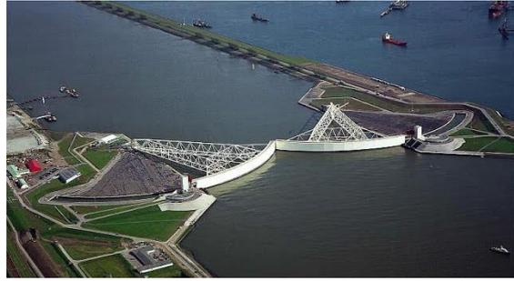
Ilustración 4-31: Medidas de protección mediante la construcción de diques fijos (en la imagen de la izquierda The Surge Barrier en Louisiana, Nueva Orleans, USA) y móviles (en la imagen de la derecha la barrera de Maeslant Kering, Países Bajos).
