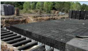
Depósitos de infiltración
