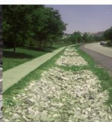
Zanjas de infiltración
