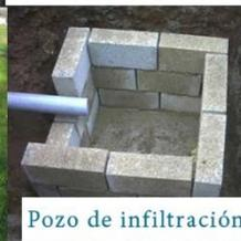
Pozo de infiltración
