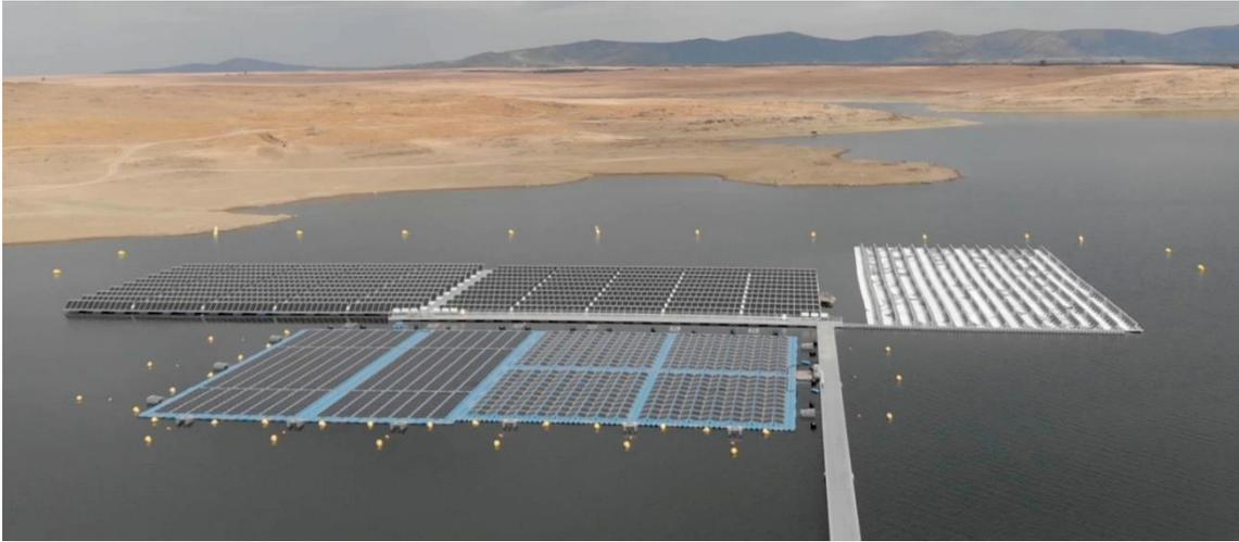
*Ilustración 4-13: Las pérdidas de agua por evaporación en lagos y embalses suponen más de 350 km<sup>3</sup> al año. Una de las posibles soluciones a esto es la cubrición de parte de la superficie embalsada con paneles solares, cumpliendo así una doble función: la reducción de pérdidas y el aprovechamiento energético (Imagen de la planta fotovoltaica flotante en el embalse de Sierra Brava en España).*
